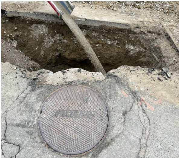
Photo 3: Concrete Pour for Encasement
